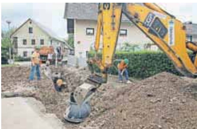
Gradbena dela v Vašci intenzivno potekajo. / FOTO: MATIC ZORMAN
